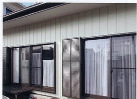
●外観は同系色のサイディングに。基礎も打ち直し、耐震性を一から考えました。
