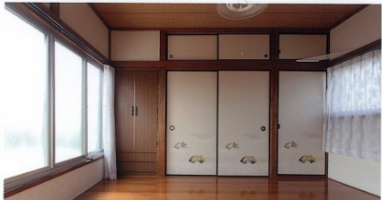
●2階床をリフォーム。壁は珪藻土塗り、2層構造のフローリングです。
