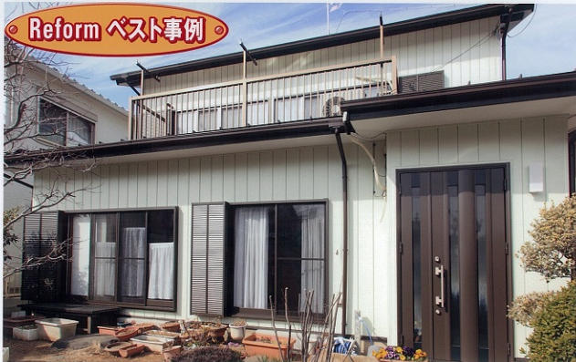
●建物外観。屋根は重い瓦から、軽いガルバリウムに。
