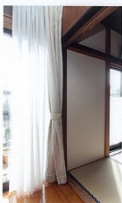
●窓枠は全数取り壊し、断熱材も入れ、断熱性能を高めました。
