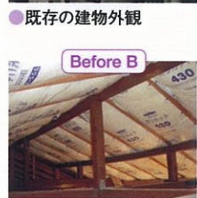
●工事中。断熱材を敷き込む様子。
